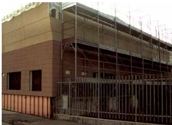
Edificio anni '70 con facciata ventilata realizzata con Efyos XPS SL, su cui il Politecnico di Milano ha monitorato le prestazioni termiche in opera.
