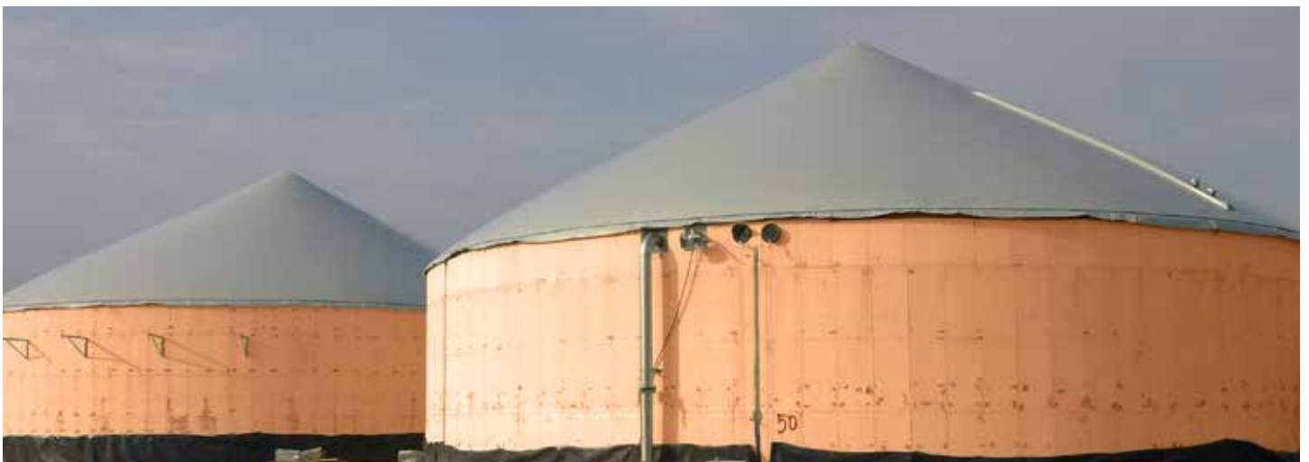
Fase di ultimazione del digestore, dopo la posa delle lastre di EFYOS XPS SL e della copertura
