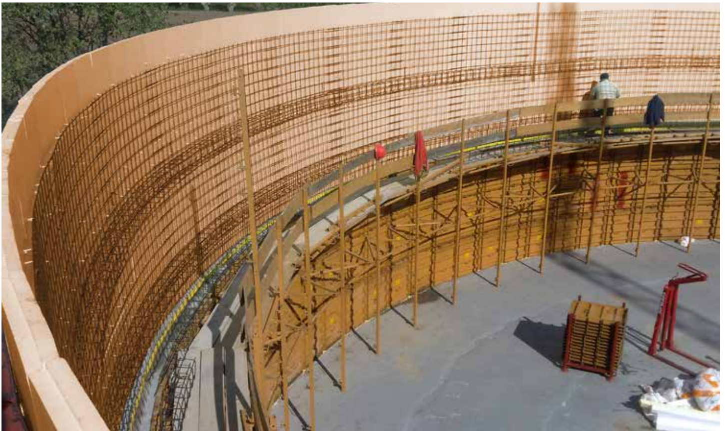
Fase di posa e armatura delle lastre di EFYOS XPS SL.
