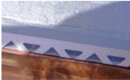
Dettaglio pannello sulla linea di gronda
