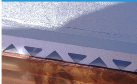
Dettaglio pannello sulla linea di gronda
