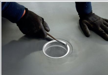
4- Controllare la saldatura tramite il **Flag Welding Tester**.
