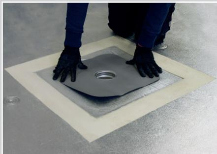
2- In caso di membrana non accoppiata a geotessuto, inserire **Draini® Flag** nel pluviale.
