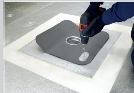
3- Fissare meccanicamente la flangia **Draini® Flag**. Un fissaggio a ogni angolo.
