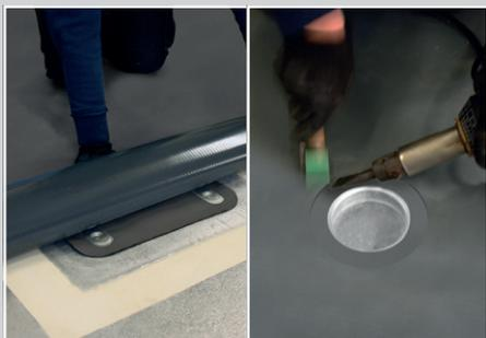
4- Saldare mediante termosaldatura la membrana sulla flangia **Draini® (PVC o TPO)**
