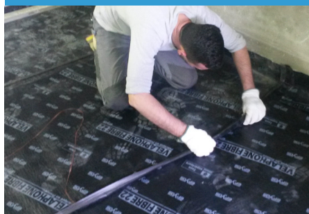
Accostamento e sigillatura dei giunti longitudinali mediante cimosa autoadesiva
