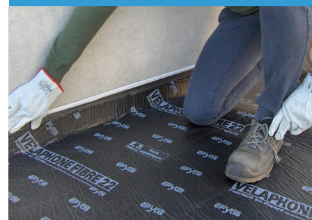
Realizzazione del risvolto verticale
