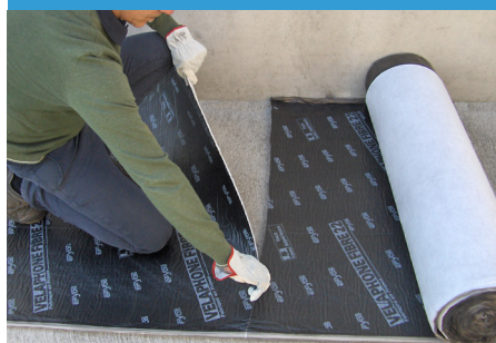
Fase di adattamento e taglio del rotolo con cutter
