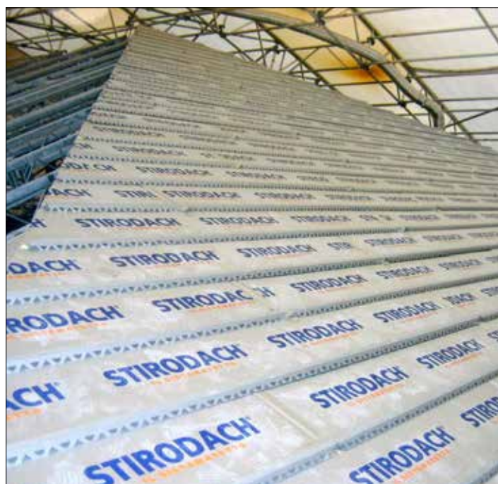
Fase di posa in opera dei pannelli Strodach su struttura a falde
