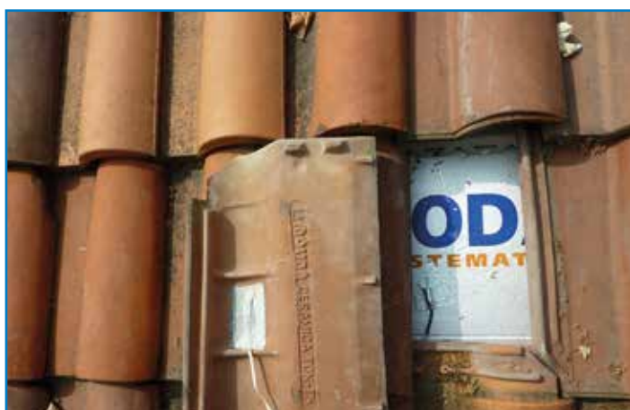
Foto 2 - Posa delle sonde di temperatura sulla copertura con alluminio
