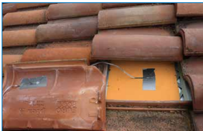
Foto 1 - Posa delle sonde di temperatura sulla copertura senza alluminio
