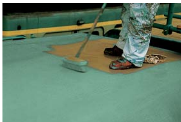
Posa in opera con spazzola.
