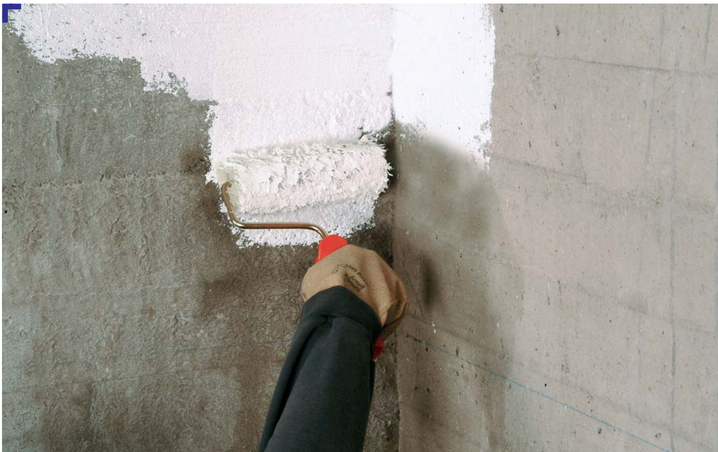
Applicazione su muro in sottosuolo
