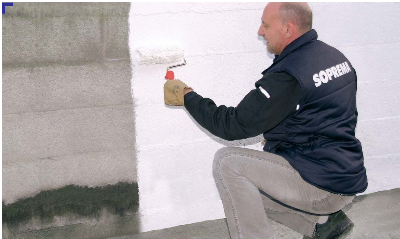
Applicazione su un muro a blocchi in cemento
