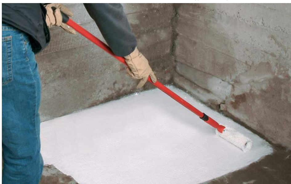
Applicazione su pavimentazione in calcestruzzo
