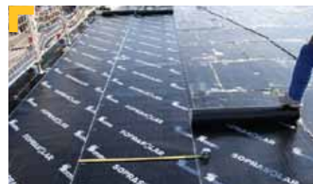
Posa del primo strato impermeabile, Soprasolar Base® (dimensione 10 m x 1 m). Si realizza la messa fuori acqua.
