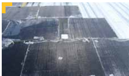
Posa dell'elemento termoisolante fissato meccanicamente
