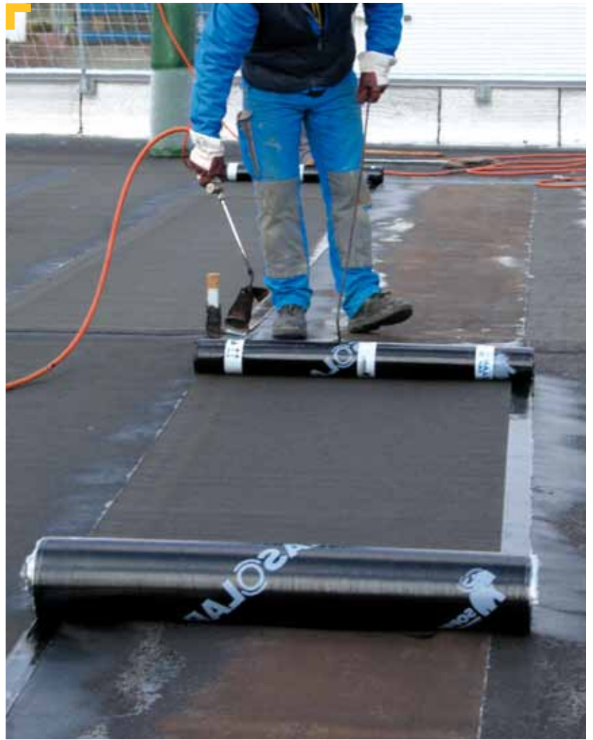
Applicazione di Soprasolar Cap®, 2° strato silicato autoprotetto
