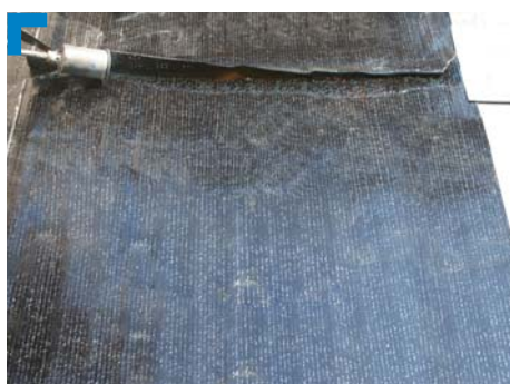
6. Sovrapposizione trasversale 10 cm. Su elemento termoisolante in polistirene 15 cm.
