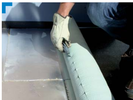
3. Tagliare il film siliconato della faccia inferiore con l'aiuto di un cutter. Procedere delicatamente per non tagliare la membrana.
