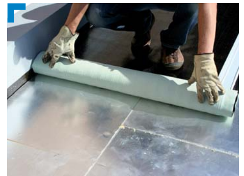
2. Posizionare il rotolo Soprastick SI , svolgendolo per la metà della sua lunghezza.
