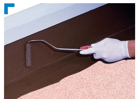
8. Risvolto verticale realizzato senza fiamma con Flashing .
