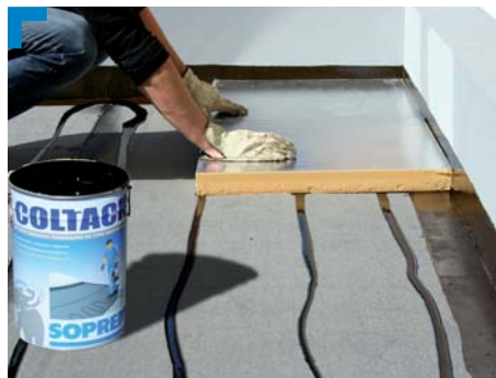
1. Sulla barriera al vapore, applicare i pannelli isolanti con una leggera pressione sulla colla Coltack .
