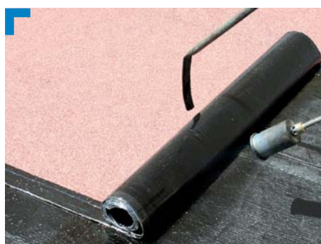
7. Posa del secondo strato Elastophene Flam 25 AR . Il secondo strato autoprotetto è saldato in totale aderenza, a giunti sfalsati. Le sovrapposizioni sono di 6 cm, saldate.
