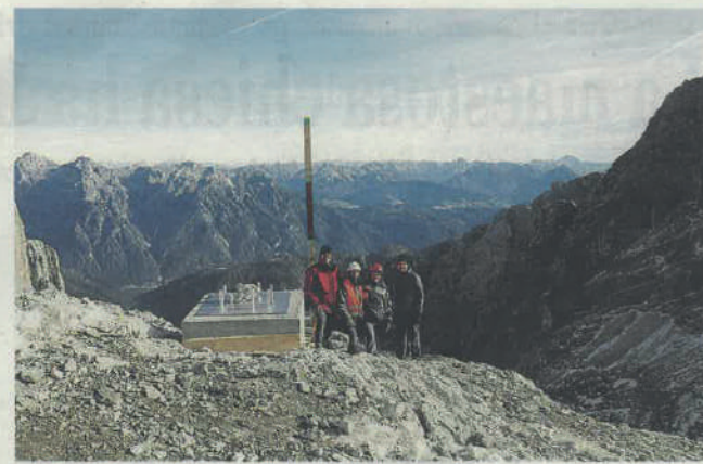
AURONZO - La squadra che il 28 ottobre ha concluso la prima fase dei lavori di costruzione.
